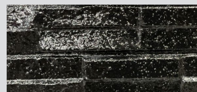
ウルトラローラーで塗布(乾燥後)
