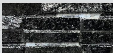
ハイパイルローラーで塗布(乾燥後)
